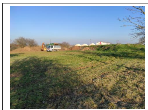
talus séparatif côté est
